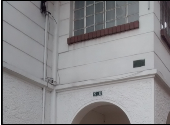
Foto No. 1 Nomenclatura del Predio 17-32
